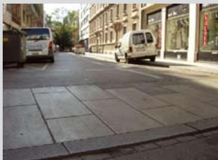
Sur ce trottoir traversant, le ressaut vertical de 3 cm de hauteur permet une détection par tâtonnement.
