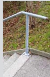
La main courante, en forme de garde-corps, offre une prise aux personnes de petite taille. La barre supérieure doit être placée à une hauteur entre 90 et 100 cm et celle inférieure à 60-65 cm environ.
