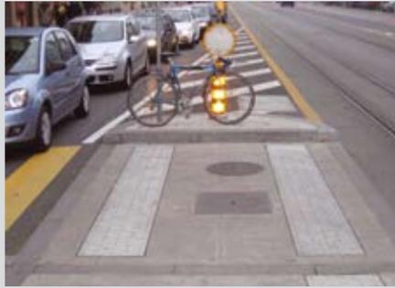
D'habitude, les **îlots intermédiaires** sont munis de signaux tactiles et/ou acoustiques seulement lorsque les feux règlent la traversée de la chaussée en deux temps. Toutefois, pour permettre une traversée confortable et sûre aux PMR se déplaçant très lentement, il est préférable de munir tous les îlots intermédiaires de ces signaux. Cette solution permet également à une personne malentendante de bien entendre le signal acoustique qui pourrait sinon être couvert par le bruit des voitures.
