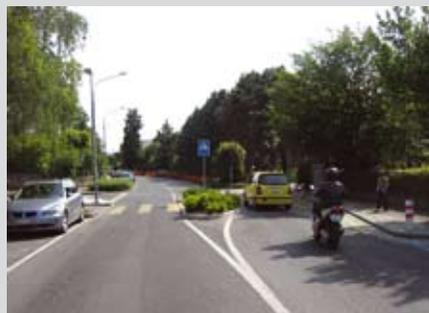
L'**îlot intermédiaire** est aussi une forme de rétrécissement de la chaussée. Lorsque sa mise en place requiert une intervention sur les bords de la chaussée, une rupture de la linéarité de la route est obtenue, ce qui oblige les véhicules à davantage de prudence.
