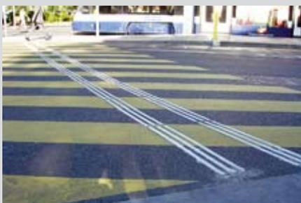
Lorsque la trajectoire des bandes jaunes d'un PPP présente un changement de direction ou ne traverse pas la chaussée de manière perpendiculaire, il faut poser des lignes de guidage sur les bandes jaunes pour conduire le piéton aveugle ou malvoyant jusqu'à l'autre bout de la traversée. Ces lignes s'arrêtent aux bandes d'éveil de vigilance des zones d'attente. Contrairement à ce qui est montré sur la photo, les lignes de guidage traversant un PPP doivent être de couleur jaune.
