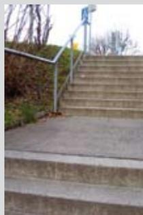
Ces deux volées d'escalier, droites, avec main courante continue et palier après 10 marches constituent un bon exemple. Les **dimensions du palier** doivent être adaptées à la longueur moyenne du pas de l'homme. En additionnant à la longueur standard d'un giron (32 cm) celle d'un ou de plusieurs pas (64 cm), on obtient des dimensions de palier adaptées au rythme de marche (96 cm, 1m60, 2m24, 2m88, 3m52, ...).
