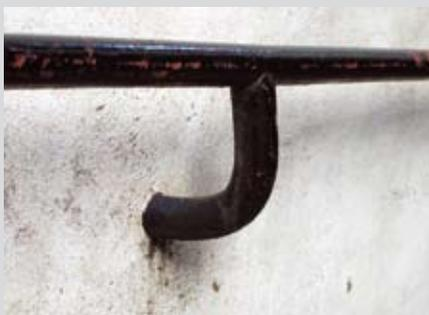
Il est souhaitable de ne pas interrompre la main courante aux changements de direction.
