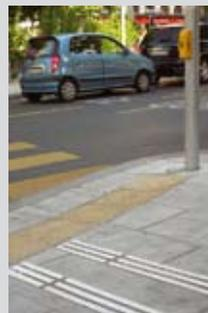
Lorsque le poteau de signalisation tactile et acoustique est positionné à l'une des deux extrémités de la zone d'attente, la bande d'éveil doit conduire jusqu'au pied de celui-ci. Les lignes de guidage devraient aussi rejoindre le poteau, contrairement à ce qui est indiqué sur cette photo.
