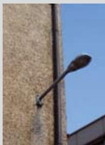
Par rapport au dispositif d'éclairage suspendu à un câble reliant deux immeubles, celui directement fixé au mur a l'avantage de mieux illuminer le bord de la chaussée. Dans tous les cas, il faut veiller à ce que l'éclairage ne gêne pas les résidents.
