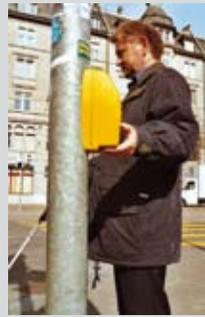
La flèche placée en dessous du boîtier du **signal tactile** indique la direction à suivre pour traverser. La direction devrait en principe être aussi indiquée par une fixation du boîtier au poteau du côté opposé au passage pour piétons (photo de droite).
