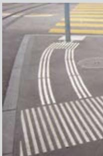
Les lignes de guidage faisant saillie de 4 à 5 mm au-dessus du revêtement sont détectables par tâtonnement.
