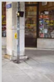
Ici, le poteau de signalisation pour piétons est posé sur le bord intérieur du trottoir (côté opposé à la chaussée). Lorsque le trottoir est suffisamment large, le positionner sur le bord extérieur (côté chaussée) évite d'augmenter la distance à parcourir pour traverser.
