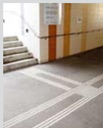
Les lignes de guidage conduisant vers le haut ou le bas d'un escalier doivent conduire à une main courante. Lorsqu'un système de lignes de guidage est également présent à l'autre bout de l'escalier, faire en sorte qu'il démarre à partir de la même main courante, comme sur la photo.
