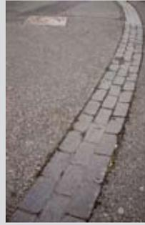
A travers la mise en place de **revêtements** aux propriétés tactiles et optiques différenciées (p. ex. enrobé versus pavé), il est possible de développer un système de guidage sur les grands espaces.
