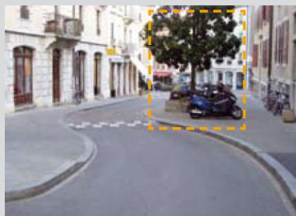
Il peut être renforcé par un rehaussement de la chaussée. La présence d'un élément vertical tel qu'un arbre renforce la perceptibilité du décrochement.
