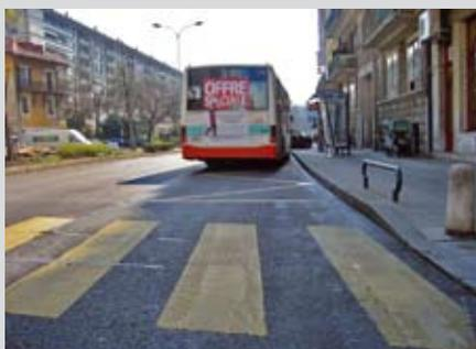
Les PPP situés à proximité d'un **arrêt de bus** doivent être aménagés derrière celui-ci afin d'éviter que le piéton qui s'apprête à traverser la chaussée soit caché.
