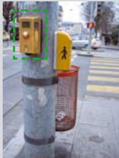
Le signal tactile et le dispositif de commande doivent être placés à une hauteur de 85 à 110 cm au dessus du sol. Le signal tactile est parfois situé sous le boîtier du dispositif de commande (boîtier entouré sur la photo).
