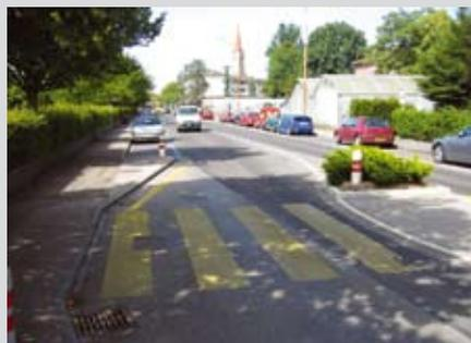
«Si la largeur de la chaussée ne suffit pas pour aménager un refuge, des interventions sont à entreprendre sur le bord de la chaussée.» (SN 640 241)
