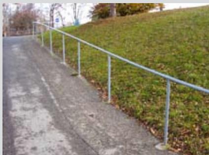
Il est parfois possible d'aménager un chemin en zigzag pour diminuer sa pente, notamment dans les parcs et autres grands espaces (photo de gauche). Si, malgré cela, la pente reste trop élevée, la mise en place d'une main courante est nécessaire (photo de droite).
