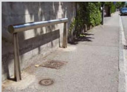
L'assis-debout a l'avantage d'être peu profond (10 à 20 cm, selon les modèles). Si celui-ci n'est pas doté d'un dossier, il est préférable de le poser à 10-15 cm d'un support tel qu'un mur pour offrir aux piétons confort et sécurité.
