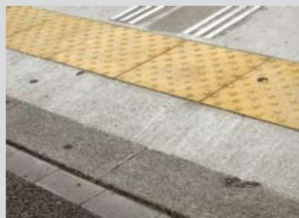
Le ressaut vertical de 1 cm de hauteur est précédé d'une bande d'éveil de vigilance. Pour des raisons de sécurité, cette dernière doit s'étendre sur toute la largeur de la zone d'attente où la hauteur du ressaut vertical est inférieure à 5 cm.
